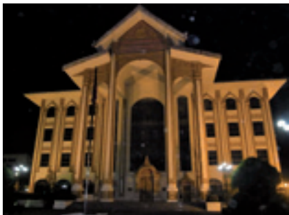
写真1 中国の援助で建てられたビエンチャン文化会館
