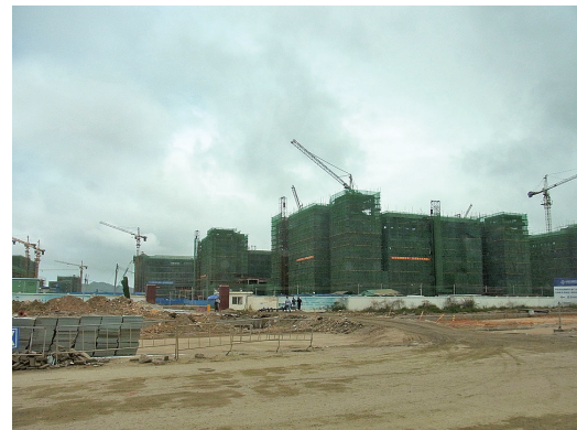
写真2 横琴新区 急ピッチで進むマカオ大学建設
