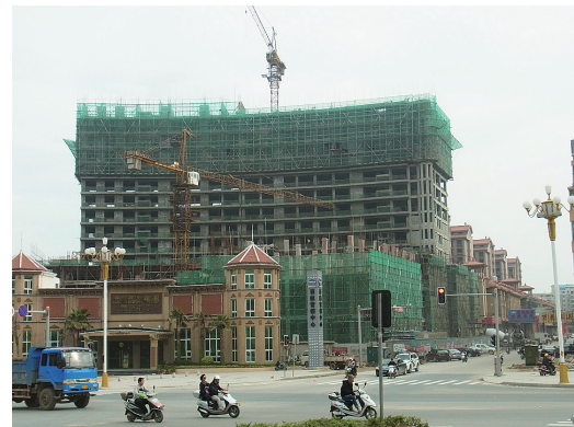
写真2 平潭島市内で進むマンション開発
